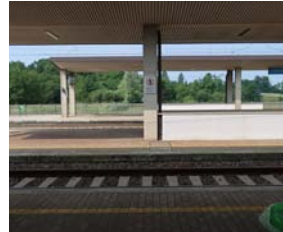
Mancato adeguamento banchine
