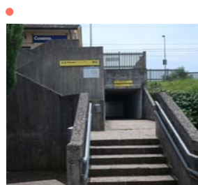
Assenza rampe e scivoli
