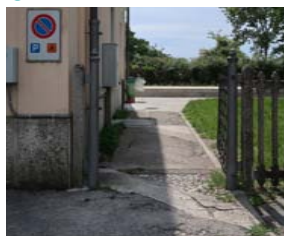
Accessibilità strada-banchina n.1
