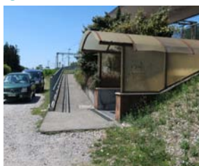
Accessibilità strada-banchina n.2
