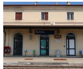
Mancato adeguamento banchine
