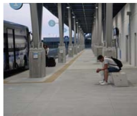
Presenza banchina coperta
