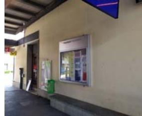
Assenza informazioni destinazioni/orari interscambio
