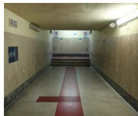
Assenza scivoli in sottopasso
