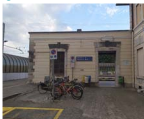
Presenza stalli biciclette in prossimità dell'edificio stazione
