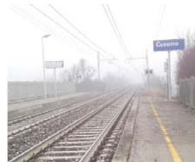
Mancato adeguamento banchine
