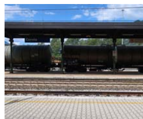
Assenza adeguamento banchine
