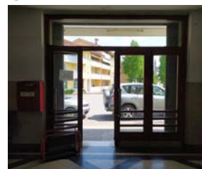
Accessibilità strada-edificio stazione-banchina n.1
