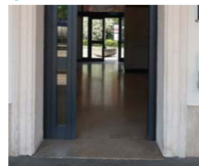
Accessibilità strada-edificio stazione-banchina
