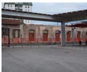
Presenza banchine coperte
