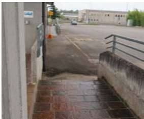
Presenza rampa strada-banchina
