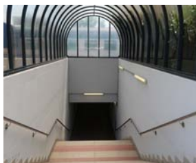
Assenza adeguata accessibilità tra banchina 1-altre banchine
