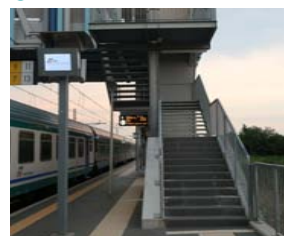
Presenza di sovrappasso dotato di ascensore
