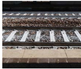
Mancato adeguamento banchine
