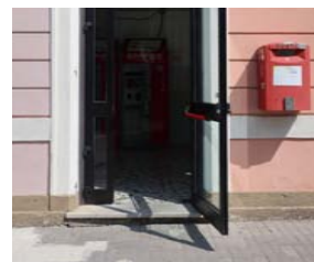
Mancata accessibilità edificio strada - stazione
