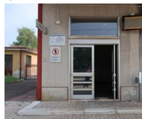
Area esterna videosorvegliata
