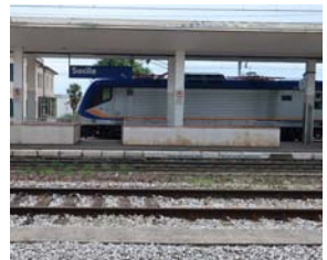
Mancato adeguamento banchine
