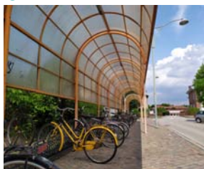
Presenza stalle biciclette coperti in prossimità dell'edificio della stazione
