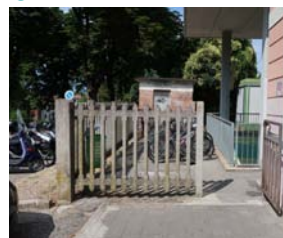
Accessibilità strada-banchina n.1
