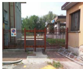
Assenza accessibilità strada-banchina 1
