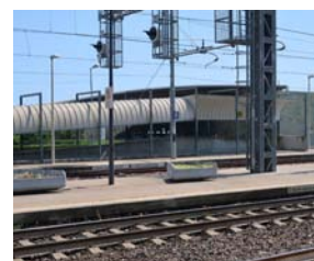
Mancato adeguamento banchine
