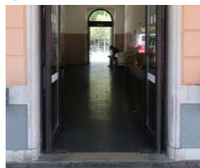
Accessibilità strada-edificio stazione-banchina n.1
