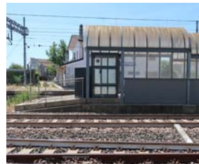
Parziale adeguamento banchine
