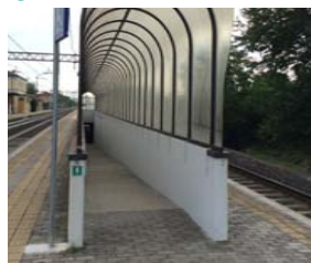
Rampa di accesso al binario 2 e 3
