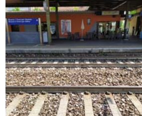
Mancato adeguamento banchine
