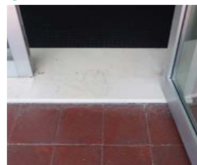
Accessibilità strada-edificio stazione-banchina n.1
