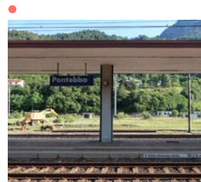
Mancato adeguamento banchine
