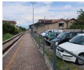
Mancanza adeguamento banchine
