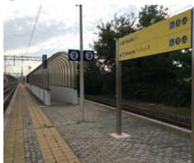
Accessibilità al binario 2 e 3 tramite rampa
