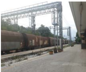
Assenza di adeguamento delle banchine della stazione
