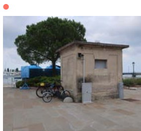
Assenza banchina coperta
