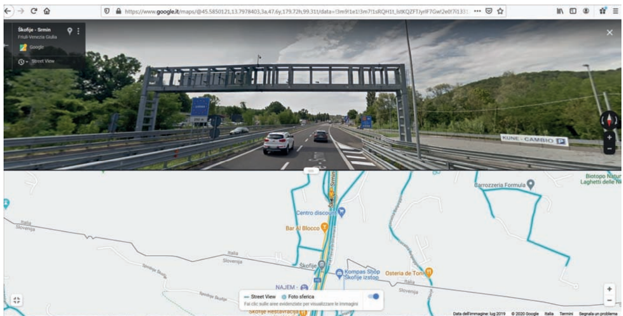
Postazione ANAS-Panama n.920044 di Muggia (TS) - NS326 km 4+403
