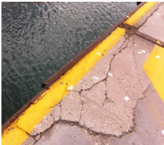
Figura 22 - Dettaglio relativo allo stato della pavimentazione della banchina; fonte: immagine di CoSEF.
