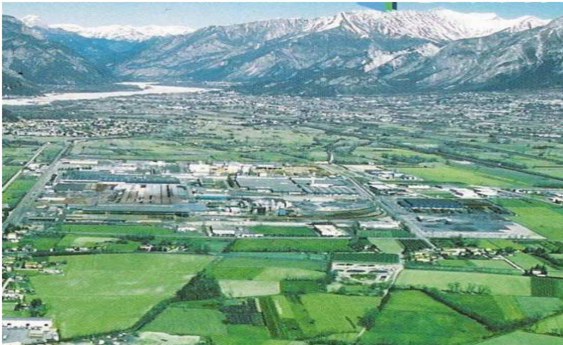
Immagine 1: vista aerea Z.I. C.I.P.A.F.
