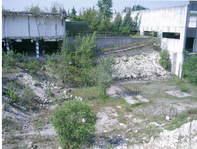
Figura 2 – Stato attuale dell'area
