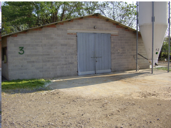
LATO NORD CAPP. n. 3
