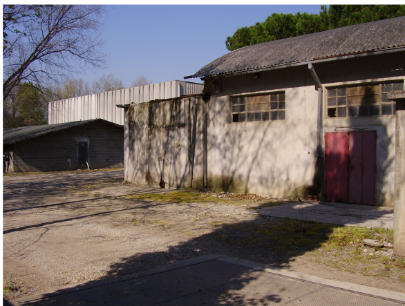
LATO SUD CAPP. n. 1 (SX FOTO) LOCALE DEPOSITO; STALLA (DX FOTO)
