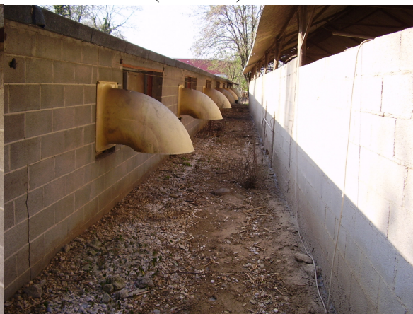
LATO EST CAPP. n. 1 (SX FOTO) LATO OVEST DEPOSITO ATTREZZI (DX FOTO)
