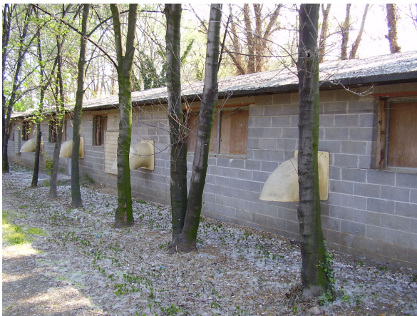
LATO EST CAPP. n. 3
