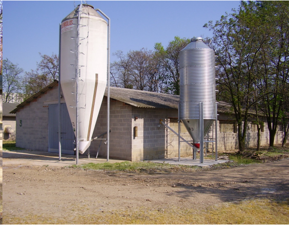
LATO NORD – OVEST CAPP. n. 3 (PARTICOLARI SILOS)
