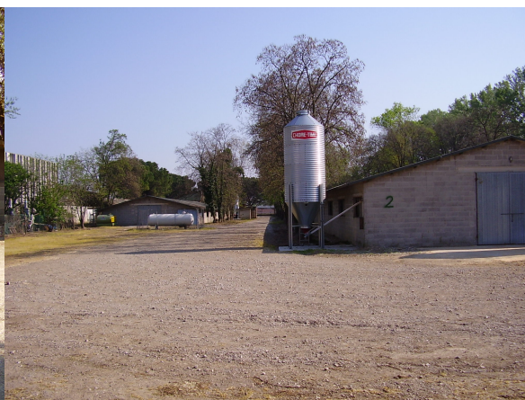
LATO NORD CAPP. n. 2 (DX FOTO) LATO NORD CAPP. n. 1 (SX FOTO)
