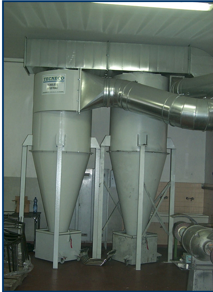
Figura 2: Sistema di abbattimento a ciclone
