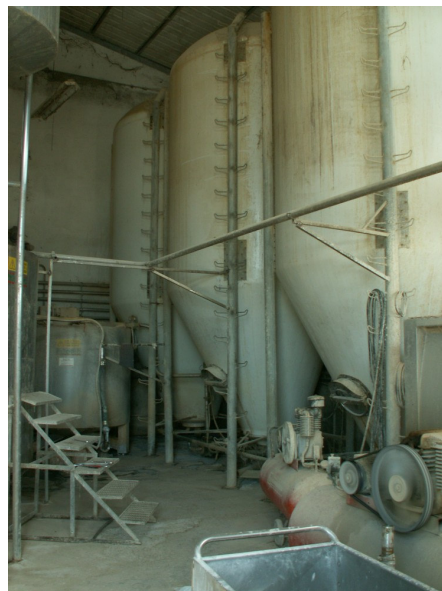
Foto 06 e 07: impianto di miscelazione cereali con importazione da silos e preparazione "ricette".
