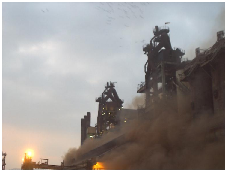
Foto 10. Ore 7:15. Sequenza con diversi fotogrammi a partire dall'inizio dell'evento anomalo fino alla fase di culmine ripresa dalla telecamera esterna all'altoforno.
