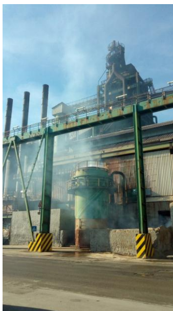
Foto 1. Ore 11:35. Episodio di accentuata fumosità in fase di granulazione della loppa proveniente dalla sommità della torre Ajo evidenziato nel corso dell'accesso in stabilimento del 23/09/2016, dovuto a un problema sul fine corsa della valvola di adduzione dell'acqua per l'abbattimento fumi.
