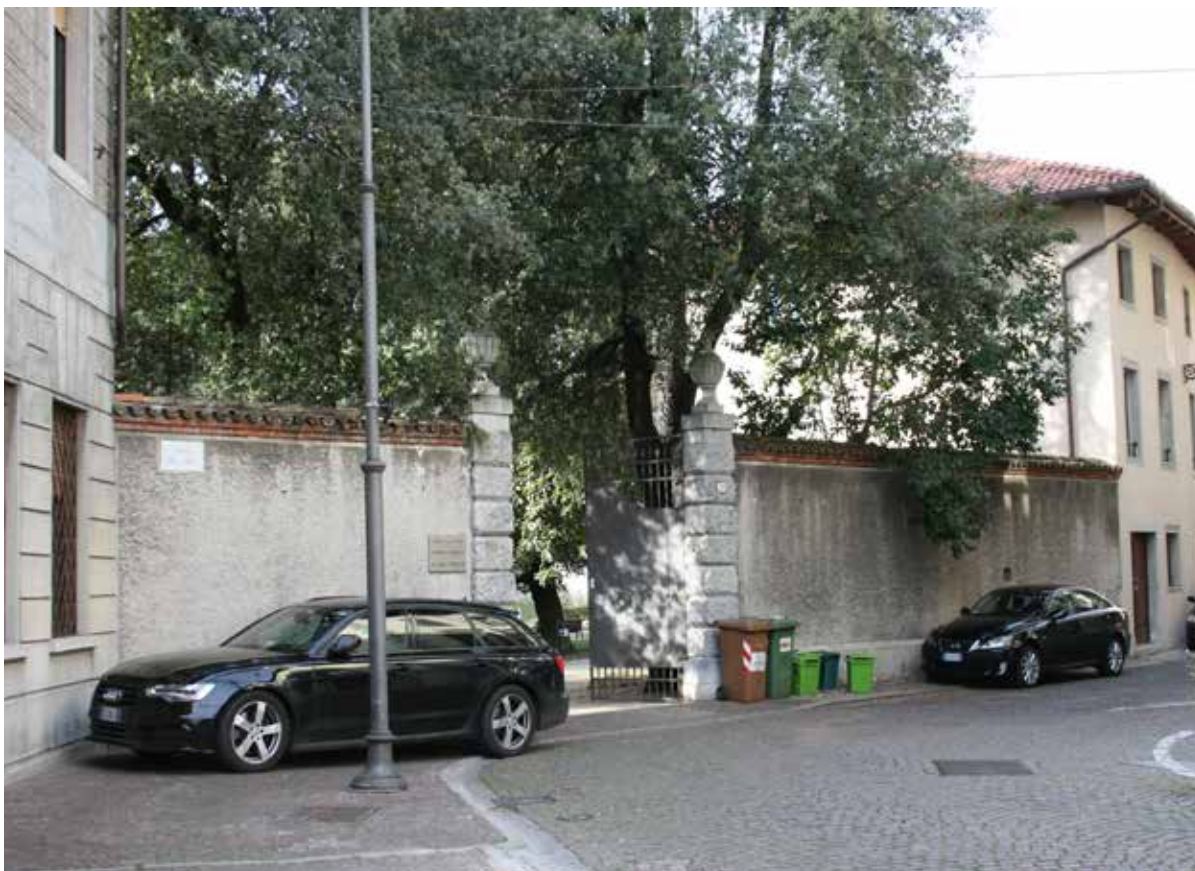
IMG_6485.JPG (ingresso sud-est)
