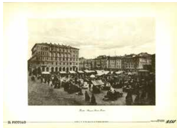
(sinistra) Foto prima della sistemazione della piazza (destra) Foto con il Mercato
