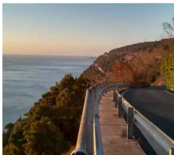
Belvedere accessibile: sovrappasso ferroviario della "Strada della Salvia" – S. Croce, veduta a nord ovest
