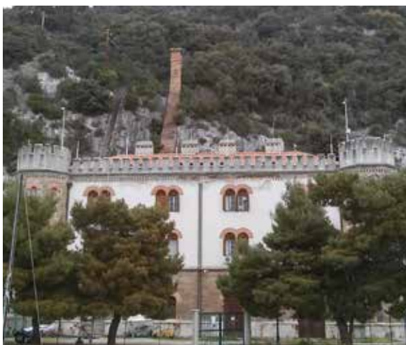
Edificio ex "Sollevamento acque" ex L.B.M. ora sede O.G.S. Porticciolo Filtri S.Croce
