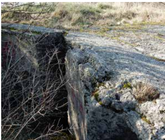
Goli Vrh: bunker
