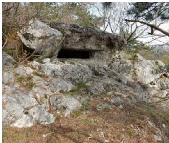
M. S. Primo: bunker
