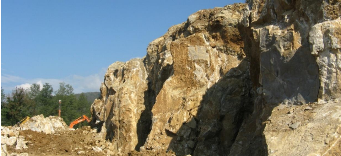
Lavori di scopertura del giacimento di Pietra Piasentina (Cava Clastra, UD)
