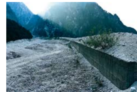
Il muro in calcestruzzo, realizzato negli anni '80 nella porzione apicale del conoide, ha deviato verso NW l'intero apporto detritico che, prima dell'intervento, si distribuiva anche verso SW.
