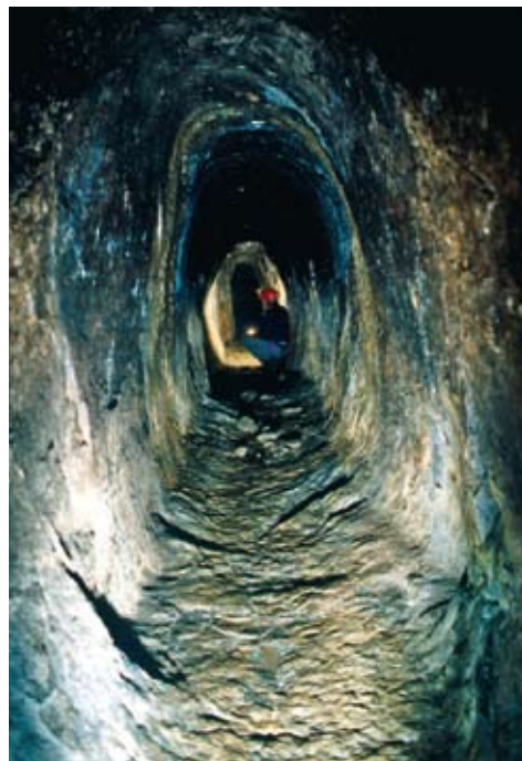
Lo scavo avveniva con il metodo dell'abbattimento con il fuoco: le sue tracce sono ancora evidenti (vista verso il fondo).
