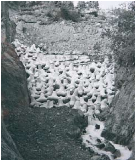
Negli anni '70 si tentò, impropriamente, di regimare il torrente con l'uso di elementi molto più idonei nelle barriere foranee. La barriera a "tetrapodi" non era adatta a sopportare l'onda d'urto delle lave torrentizie e fu scalzata l'anno successivo.
