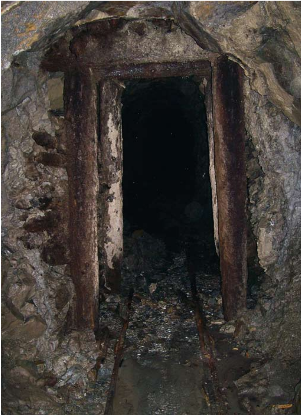
Uno degli ultimi tratti di galleria che conservano sia i sostegni lignei che le tracce dei binari lungo i quali venivano spinti i carrelli con il materiale grezzo.
