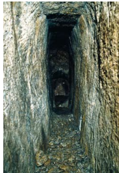
La galleria mostra una sezione ad "ogiva", tipica dell'attività mineraria medioevale, ed il soffitto piatto nell'area in scavo.
