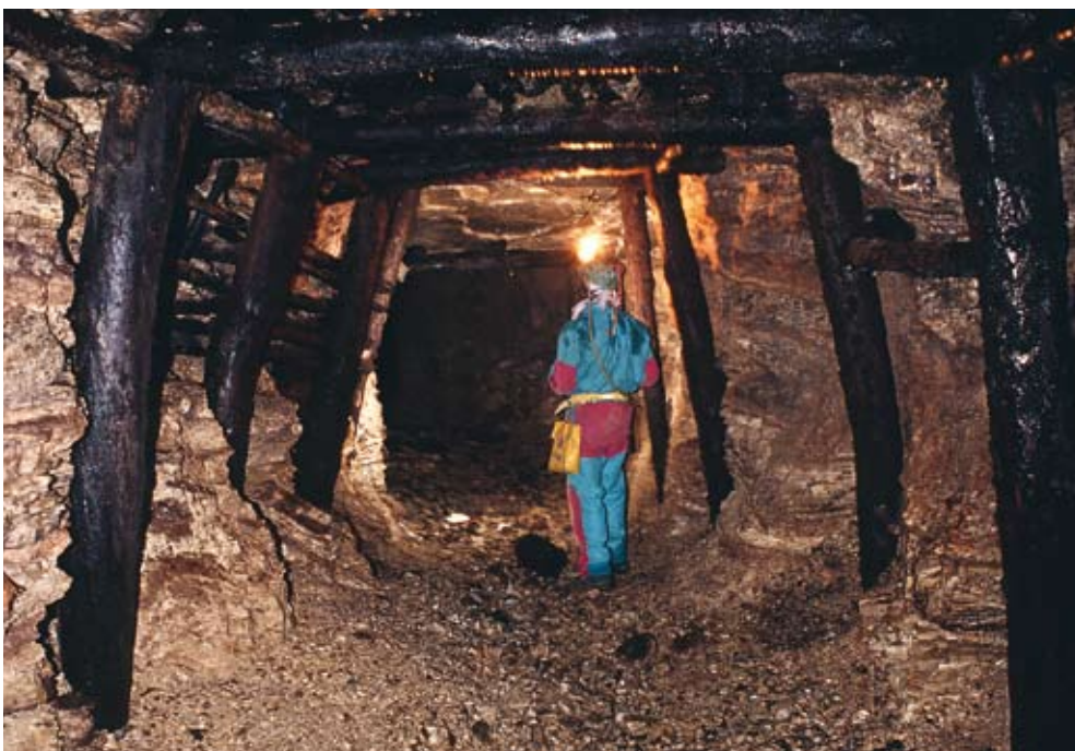
La miniera del Rio Resartico presenta una costante sezione rettangolare. Alcuni tratti erano stati rinforzati a causa dei crolli che avvenivano con una certa frequenza.
