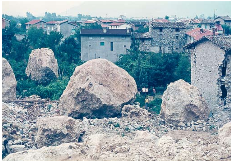
Una immagine della frana di Braulins, conseguenza del terremoto del 1976: grossi massi franati avanzarono oltre la rottura di pendenza al piede del versante, rotolando per una trentina metri, investendo e talora distruggendo alcuni edifici.
